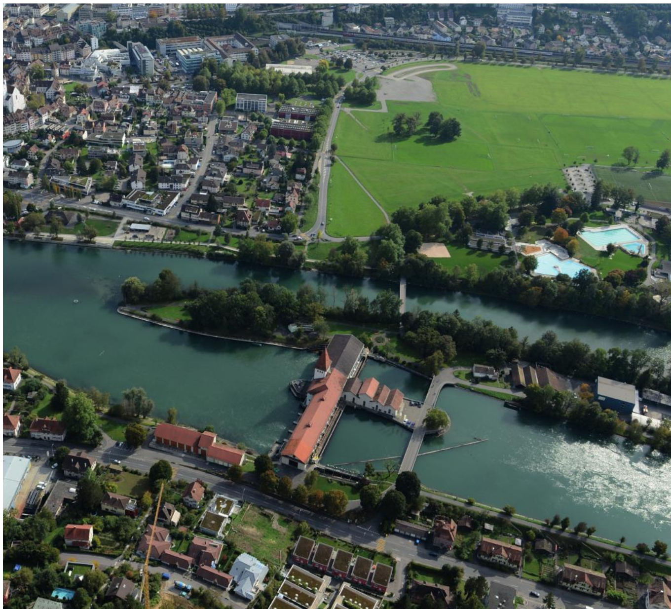
Centrale hydroélectrique fluviale de IBAarau
