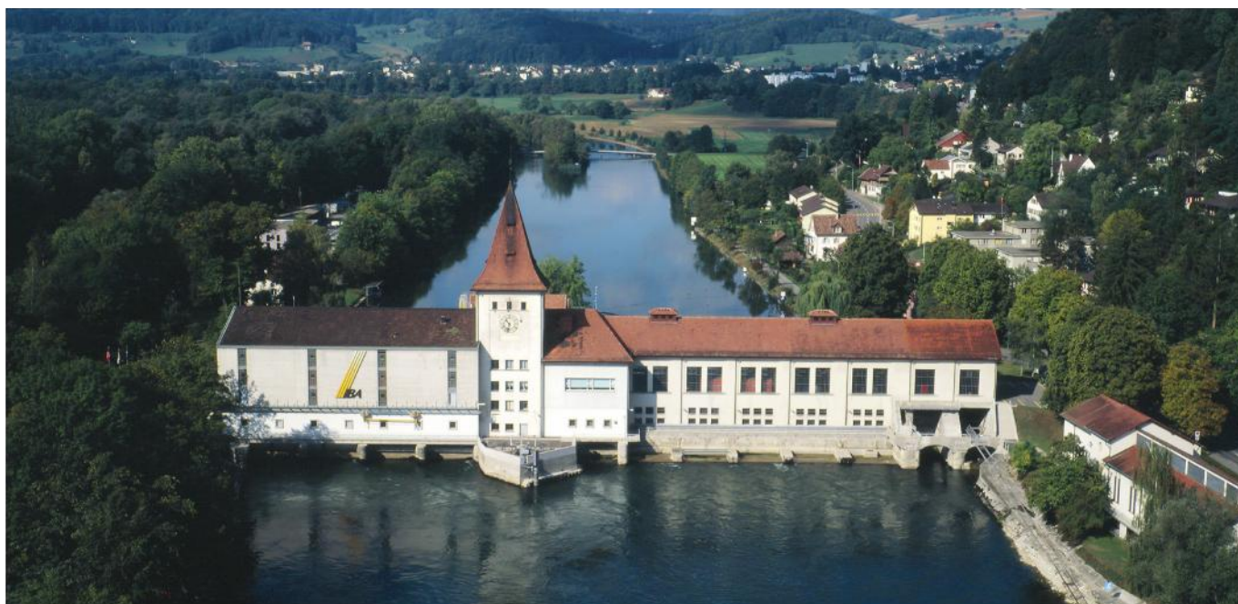
Centrale hydroélectrique fluviale de IBAarau
